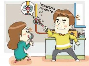
\* Для проверки утечки газа из трубы или заглушки необходимо проводить проверку герметичности используя мыльную воду или контрольную жидкость.
